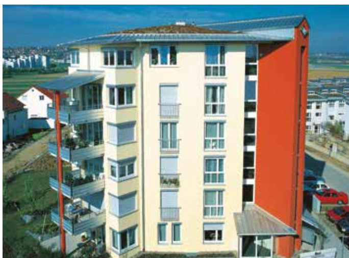
Wohnanlage Bonlanden mit Gründach, Filderstadt (D) Profiltyp: 65/333, stucco-dessiniert Architekt: Thomas Baur
