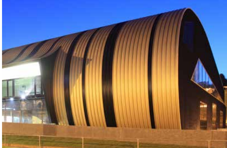
Deichhalle Ettelbrück (L) Profiktyp: 50/333, AluPlusPatina Gold G 30, RAL 9005 Architekt: Besch da Costa Architectes, Luxembourg
