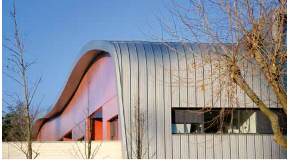
Biologisches Institut der Universitätsklinik Dijon (F) Profiltyp: 65/400, AluPlusZinc Architekt: AIA Atelier de la Rize Architectes – Albert Constantin, Lyon
