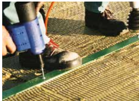
Befestigen der Schiene mit Spreiznieten
