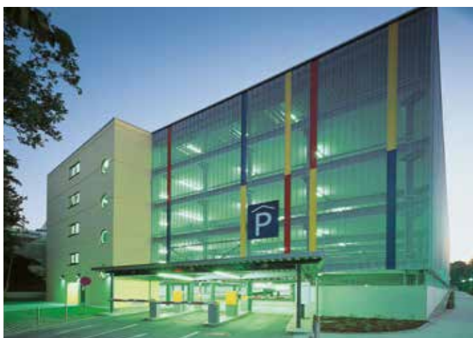
Uniklinik Ulm (Parkhaus), Ulm (D) Architekt: Scherr + Klimke
