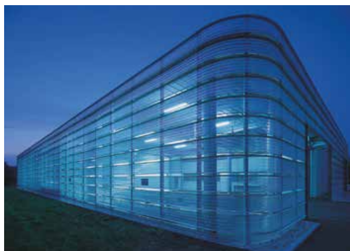
Industriegebäude Steba, Ottmang (A) Architekt: Arch. Dipl.-Ing. Ivo Kux
