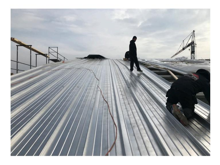
Seine Kompetenz bei der nachhaltigen Sanierung von großen Industriedächern auch bei anspruchsvollen Bedingungen stellt Kalzip beim Bauen im Bestand regelmäßig unter Beweis. Alte Dacheindeckungen aus unterschiedlichen Materialien lassen sich durch den Werkstoff Aluminium langfristig ersetzen. Kalzip Systeme sind einfach zu verarbeiten, wartungsarm und halten auch den extremen Bedingungen des rauhen Seeklimas und aggressiver Atmosphäre lange stand.
