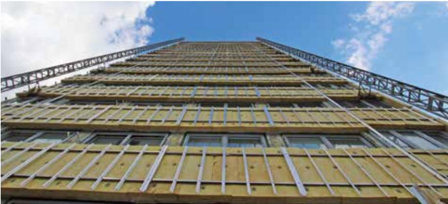
Aluminiumendstücken, kann sich variabel anpassen und hat nahezu dieselben mechanischen Leistungsdaten wie eine Standard-Aluminium-Unterkonstruktion. Zwischen die schlanke Unterkonstruktion kam schließlich die 16 cm starke Wärmedämmung aus Mineralwolle. Davor wurden als Wetterhaut die Kalzip FC Paneele montiert.
