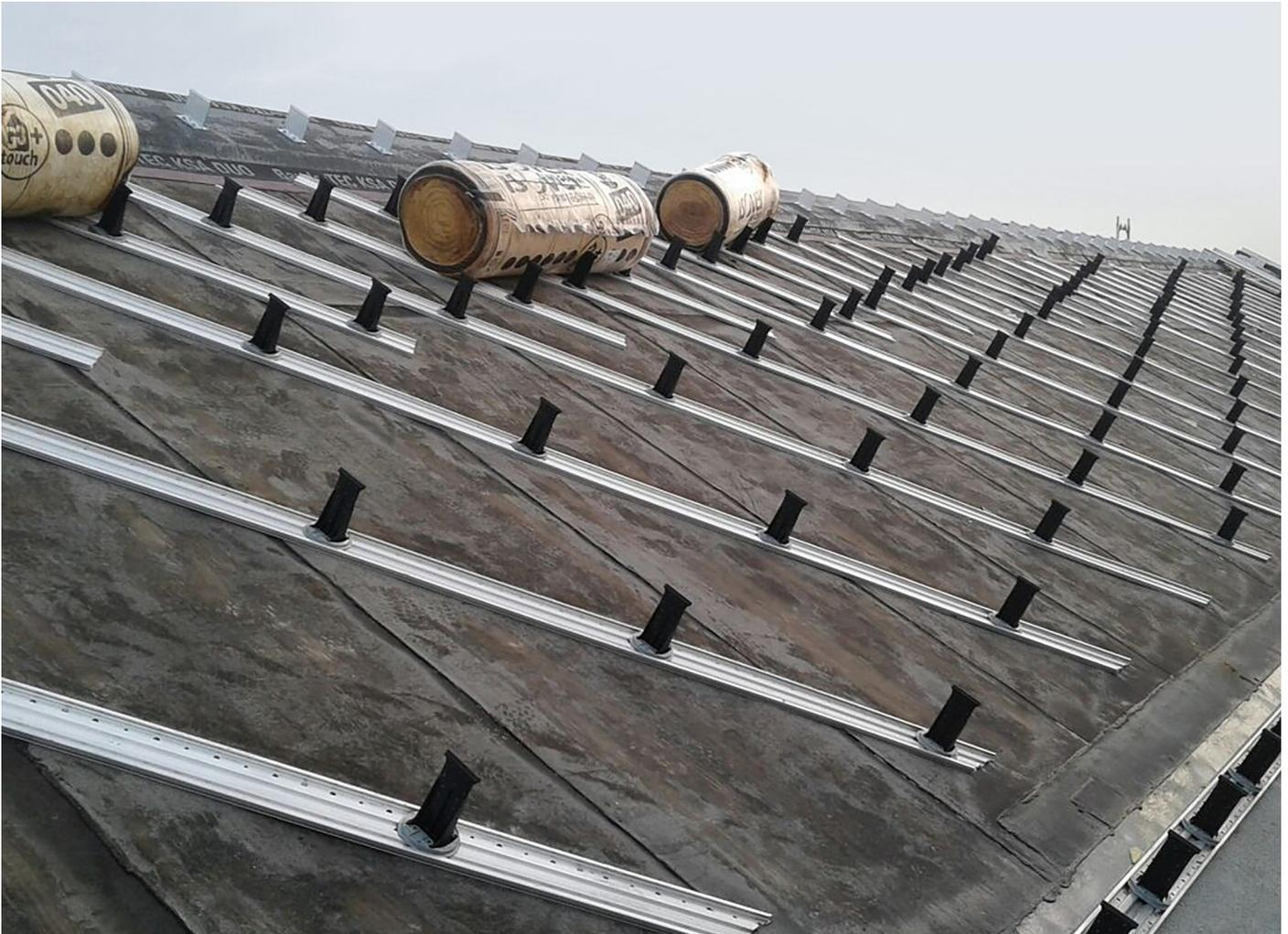
Deshalb entschieden sich die Projektverantwortlichen schließlich für die Kalzip Profiltafel aus Naturaluminium stucco-dessiniert als die passende technische und ästhetische Lösung. Da sich die Betonschraube TI von SFS im 3,0 cm starken Spiegel der Spannbetonhohl- dielen befestigen ließ, konnte die Kalzip Drehklippschiene diagonal auf der vorhandenen Betondecke verlegt werden. Zuvor war eine neue Dampfsperbahn aufgebracht worden. In die Drehklippschiene wurden dann die E 100
