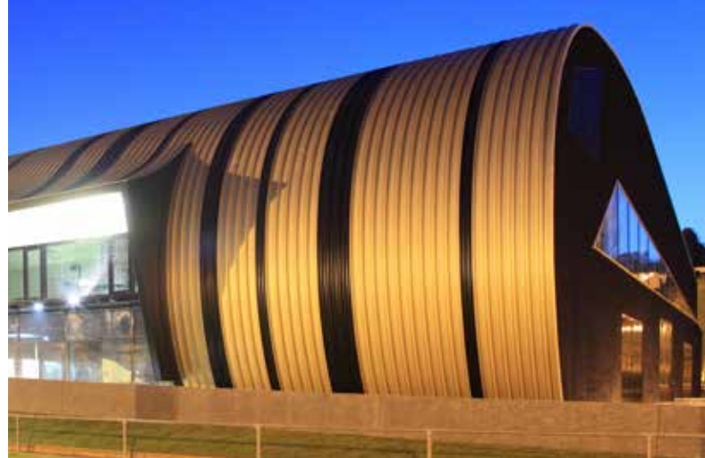
Deichhalle Ettelbrück (L) Profiktyp: 50/333, AluPlusPatina Gold G 30, RAL 9005 Architekt: Besch da Costa Architectes, Luxembourg
