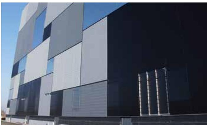
Richtungsunabhängige Montage der Kalzip FC Paneele.
