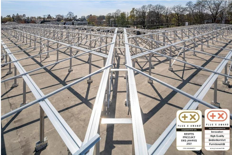
*Die Unterkonstruktion des Kalzip Vario LB Systems ist der Schlüssel zur maßgenauen Sanierung. Mit ihr können verschiedene Dach-Geometrien umgesetzt werden. © Kalzip GmbH*
